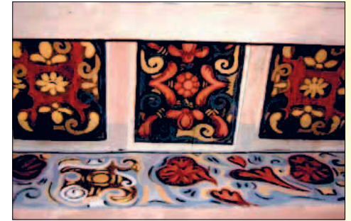
Dopo il restauro
