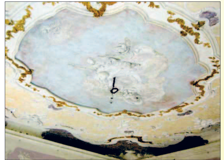
Dopo il restauro
